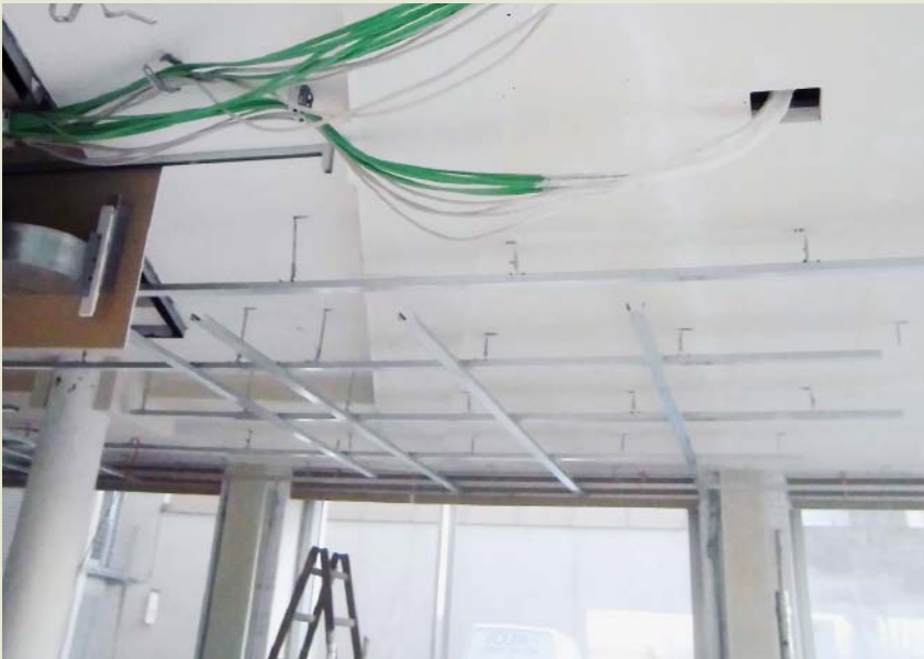
Durch die Brandschutzdecke. Die geringe Abhängöhe stellte eine Herausforderung für die Montage der Decke dar. Nichtsdestotrotz wurde sauber gearbeitet.
