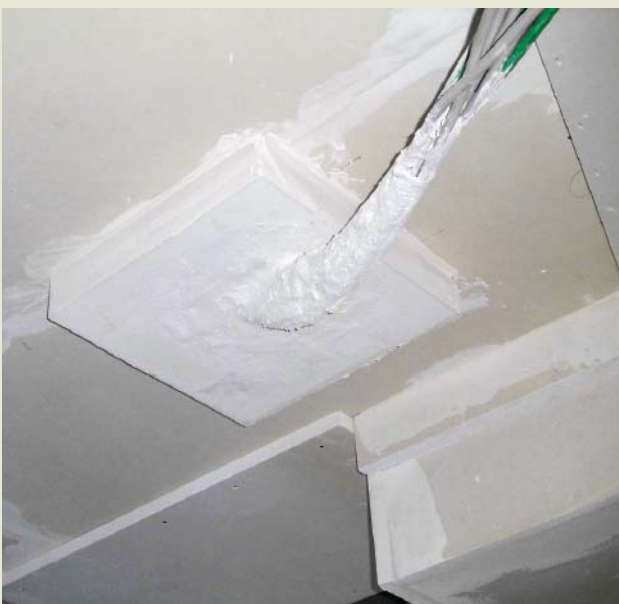
Durch die Brandschutzdecke. Die geringe Abhängöhe stellte eine Herausforderung für die Montage der Decke dar. Nichtsdestotrotz wurde sauber gearbeitet.
