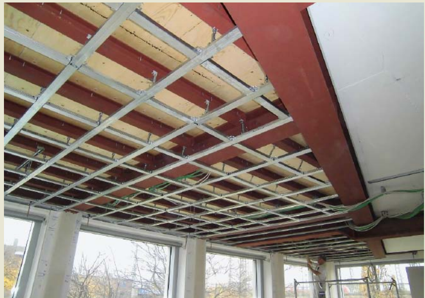
Decke 1. Die Brandschutzdecke ist eng unter die Rohdecke gezogen. Oberhalb der Decke wurde eine 30 mm starke Lage Gipsfaserplatten als F90-Konstruktion und Tragebene montiert.
